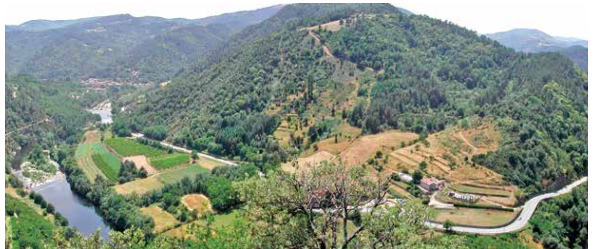
Exemple de projet innovant orienté sur les entreprises agricoles : un partenariat entre l'intercommunalité Val'Eyrieux et la Chambre d'agriculture a permis de développer un volet agricole d'aide aux projets d'économie d'énergie.
